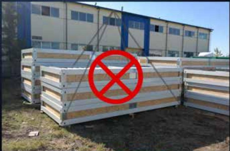
**Fiecare container trebuie așezat pe o platformă de beton plană sau pe un fundament format din cel puțin 6 puncte de susținere.**
