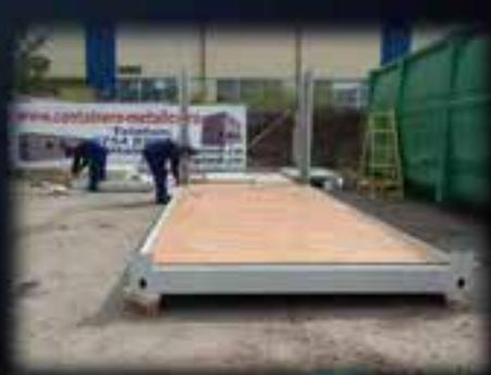
**Se poziționează elementele componente pe podea, se montează elementele de mascare (OSB), se fixează stâlpii mici pentru împachetare și se poziționează/fixează tavanul.**
